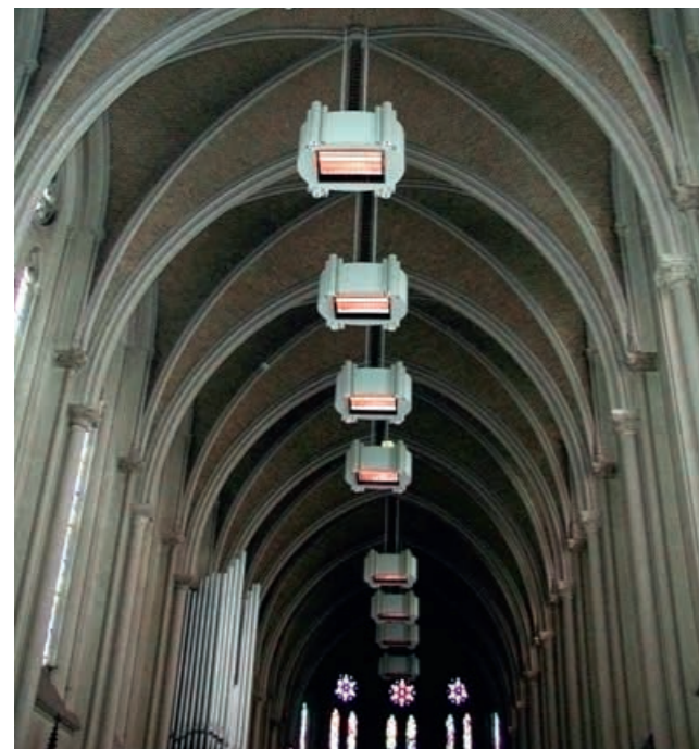
Les radiants lumineux sont appropriés pour chauffer des espaces particulièrement hauts et doivent être installés à une hauteur de plus de 6 m.
