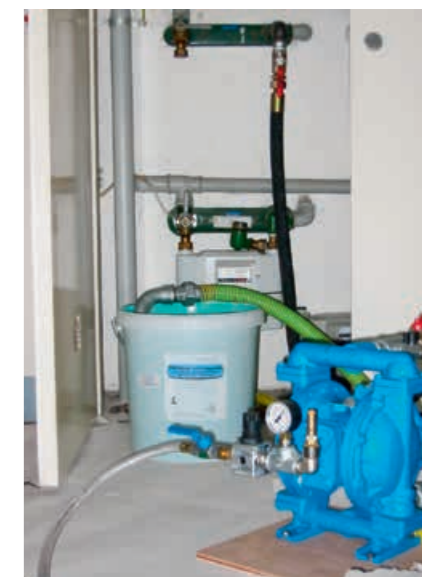
Les tuyauteries intérieures sont remplies d'un liquide d'étanchéité à l'aide d'une pompe.
